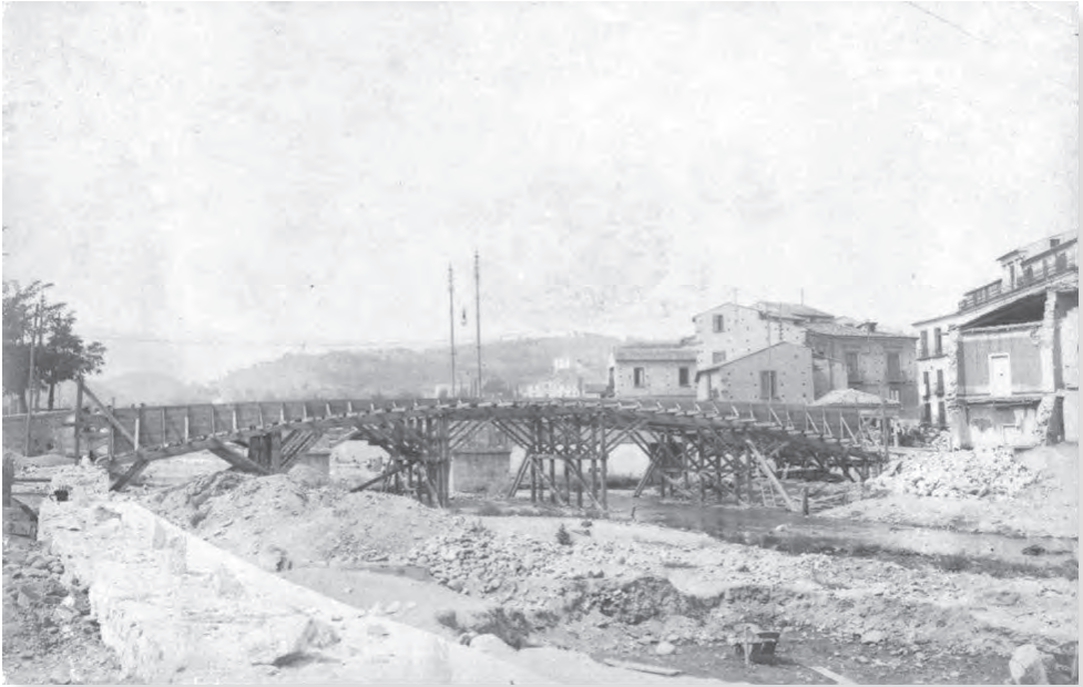
Ponte San Domenico in costruzione, 1913 (Collezione Gentile)
