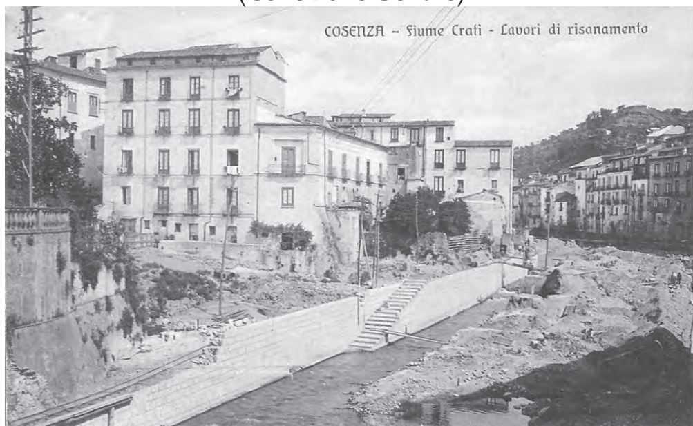
Fiume Crati - Lavori di risanamento, 1913 (Collezione Salzano)
